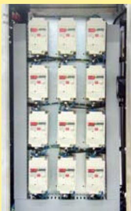
inversores de frecuencia para el control de tensión individual de cada cinta
